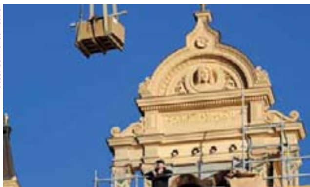
Die Kisten mit den Einzelteilen der Lüftungsanlage schweben per Kran ins Dachgeschoss des Schlossgartenflügels.
