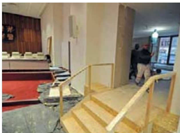
Für Barrierefreiheit im gesamten neuen Plenarbereich musste der Fußboden in der Lobby angehoben werden. Den tiefer liegenden alten Saal betritt man jetzt über diese Stufen.
