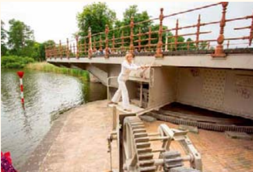
Traditionell wird zum Tag des offenen Landtages die historische Drehbrücke geöffnet, diesmal durch die 1. Vizepräsidentin des Landtages Beate Schlupp.
