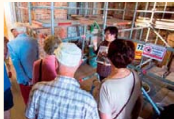
Zahlreiche Gäste interessierten sich für den Stand der Baumaßnahme im Bereich des Alten Plenarsaals.
